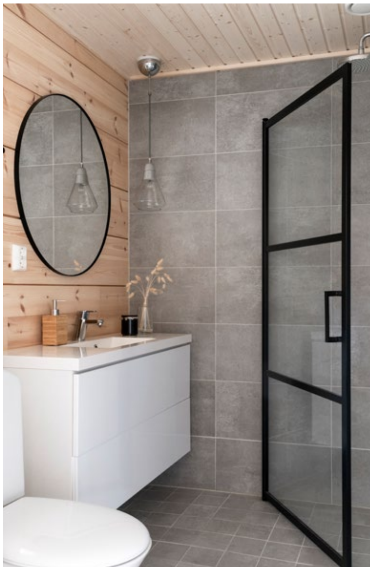
Kylpyhuoneen seinälaatat on PA City Grigio 30x60 cm, lattiasa on sama laatta koossa 15x15 cm. Puolet seinistä on jätetty hirrelle, koska puun sävy tuo lämpöä myös tähän tilaan. Kylpyhuoneen käyttöä helpottava suihkuseinä on kääntyvä.
